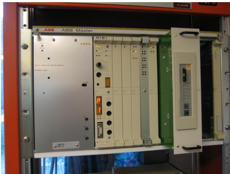
Figur 10 Skjut in det nya NDDD 001 kretskortet i MasterView ramverket.
